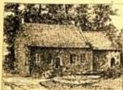
ANNEXE CONSERVEE DANS LEUR ETAT ANCIEN
